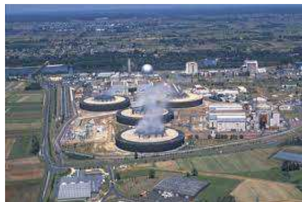
Centrale nucléaire de CHINON
